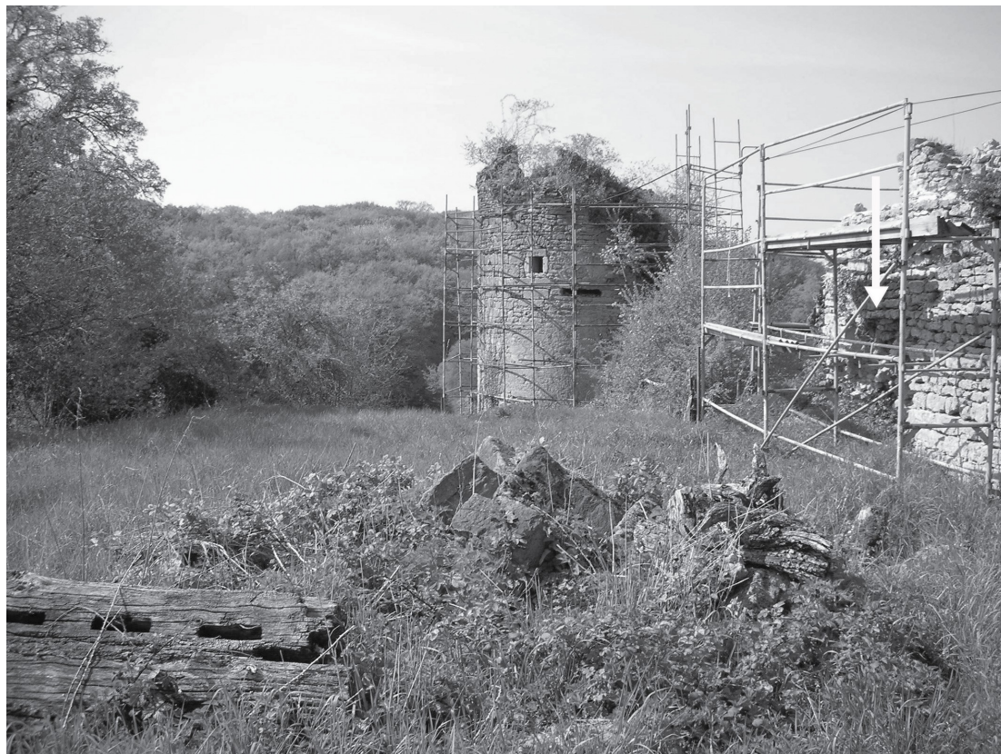
Illustration 12: Vue du sondage avant les travaux. La tour visible est la tour de la Garenne. Les échafaudages présents ont été une contrainte supplémentaire lors du décapage à la pelle mécanique. La flèche blanche pointe la portion de muraille qui a été restaurée en priorité. (Cliché C.V.)
